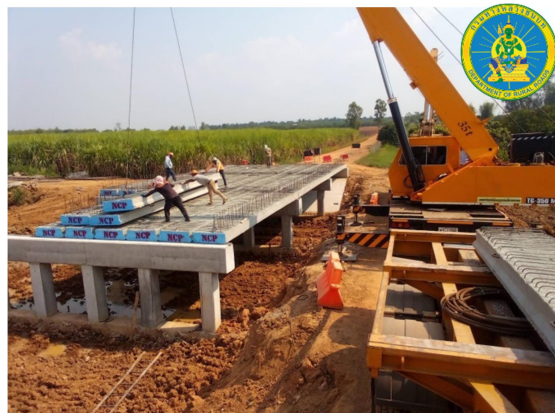
ก่อสร้างสะพานข้ามคลองกันตะนาวใหญ่ ม.17
