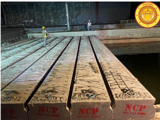
BOX 15 สายพัฒนาคุนน้ำริมถนนวิภาวดีรังสิต ตอน 2
