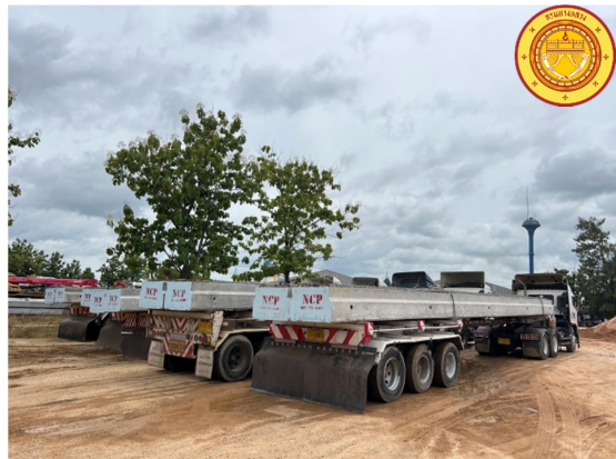
โครงการก่อสร้าง ถนน กลางเมืองวังสมบูรณ์
