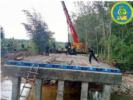
ก่อสร้างสะพานข้ามคลองกันพระปลัด ต.พิมพา
