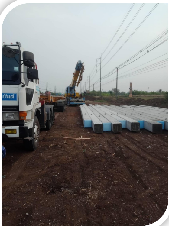
เสาเข็มพร้อมตอก ถนน ทล.365 และอีกหลายเส้น งานส่วนราชการ กองบิน 3
