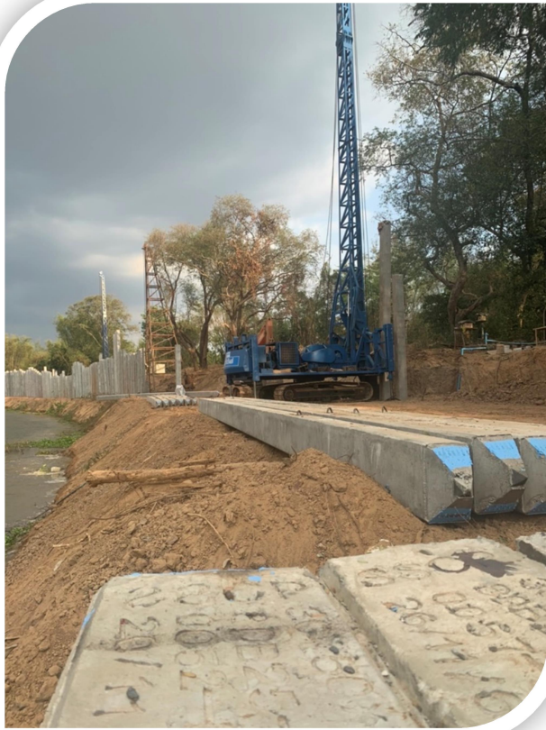
เสาเข็มพร้อมตอก งานระบบป้องกันน้ำท่วม อ.ศรีมหาโพธิ จ.ปราจีนบุรี และอื่นๆอีกหลายแห่ง เสาเข็มพร้อมตอก เขื่อนป้องกันตลิ่งวังตาล อ.กบินทร์บุรี จ.ปราจีนบุรี
