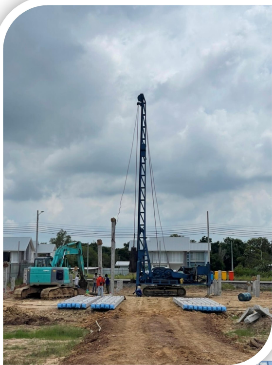
เสาเข็มพร้อมตอก ถนน ทล.365 และอีกหลายเส้น งานส่วนราชการ กองบิน 3
